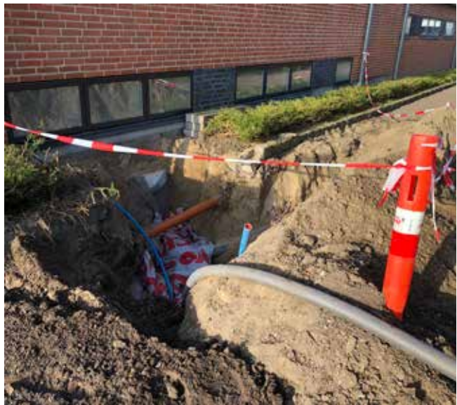
Etablering af ny vandforsyning til mandskabsbygningen.
